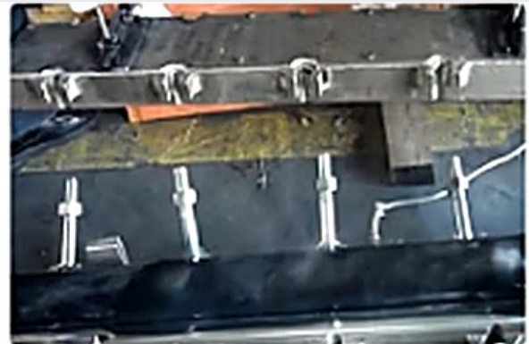
④ 핸드레일 열처리 완료 전경
