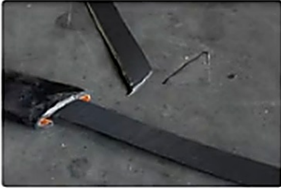
① 파손 부위 절단 후 철심 적출 작업
